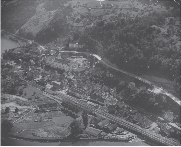
Luftbild der Spinnerei Murg Gewerkschaft Bau und Industrie Photograph, F_5031-Fd-0012 Labor Murg, 1957
