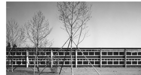
1954/57, Max P. Kollbrunner, Schulhausanlage Luchswiesen, Zürich 23
