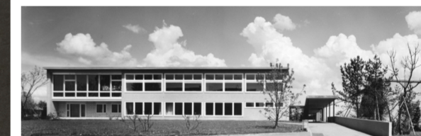
1954/57, Max P. Kollbrunner, Schulhausanlage Luchswiesen, Zürich 27
