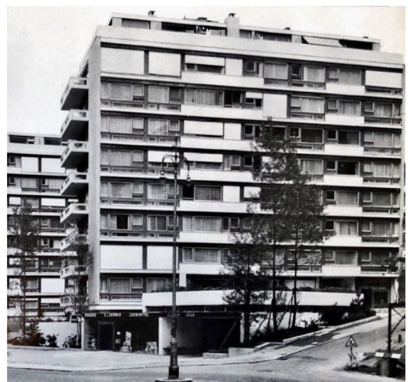
1956/59, Otto Glaus, Wohnhochhäuser City-Park, St. Gallen 14
