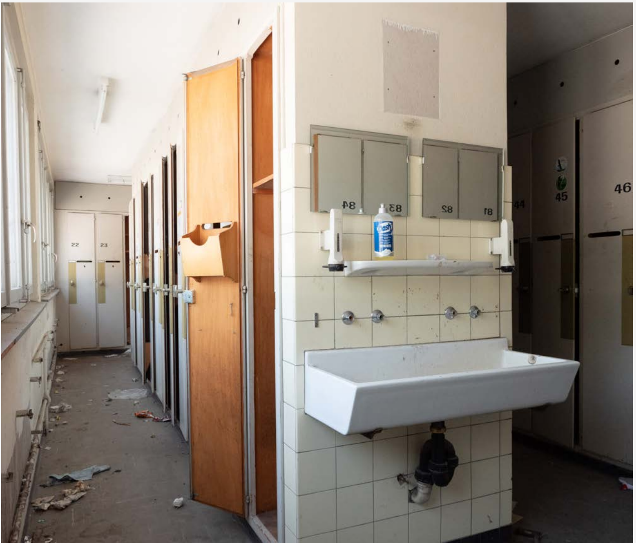
Dienstgebäude 02 Brig, ehemalige Personalgarderobe
