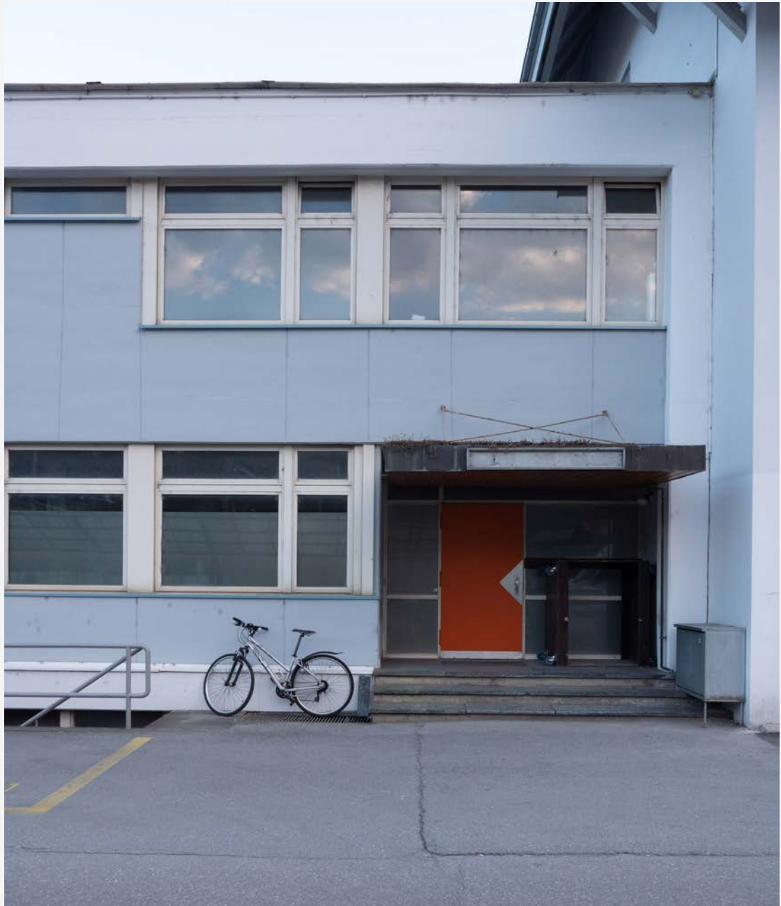
Grenzsanität Brig, Eingang Nord
