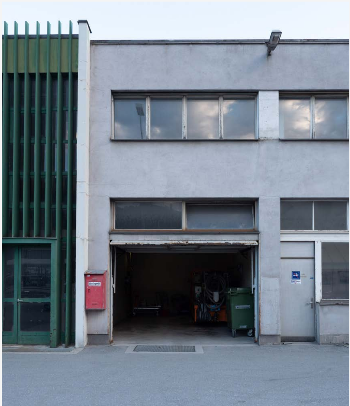
Dienstgebäude 02 Brig, Eingang Nord
