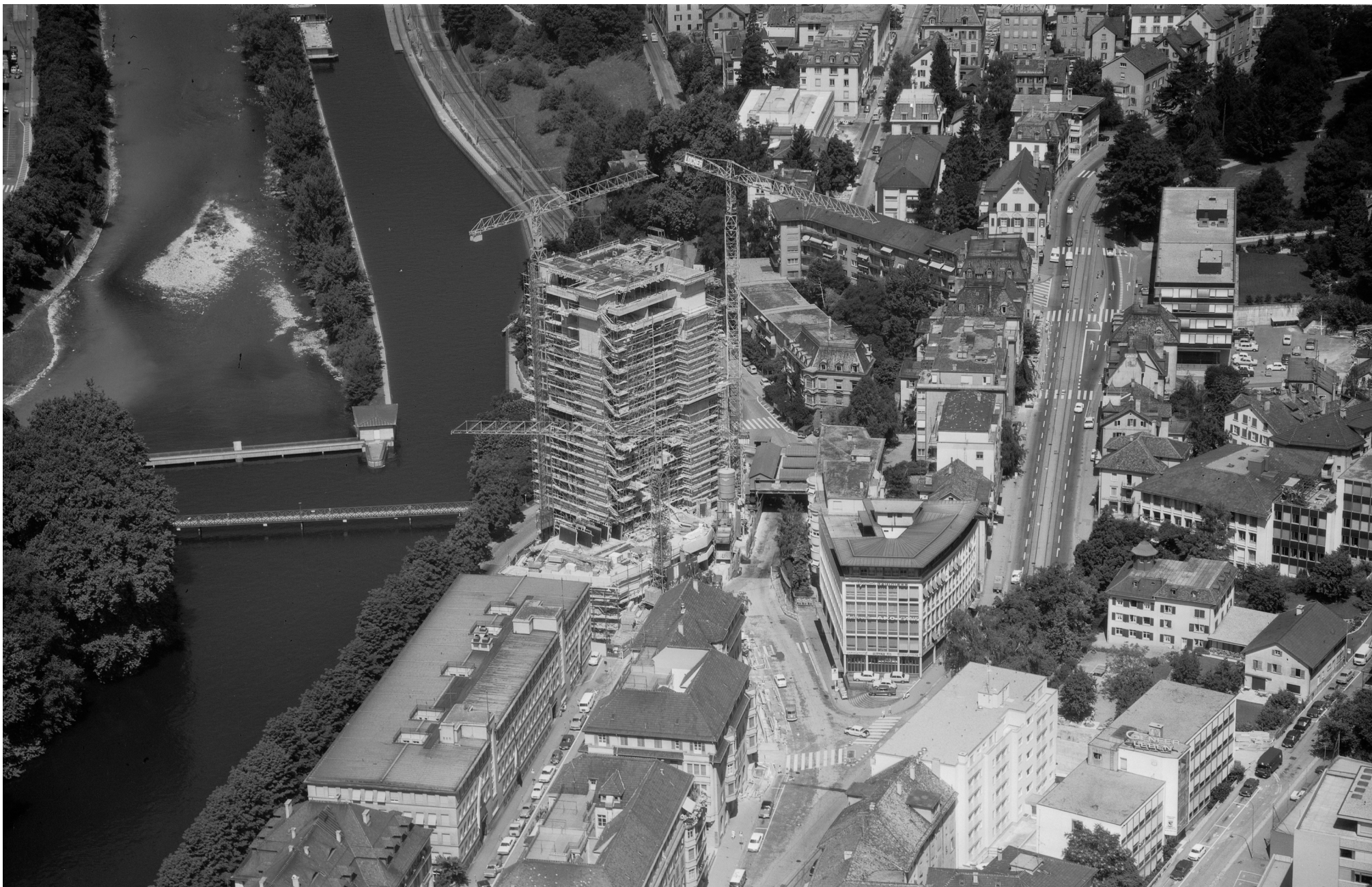
Hotel Zürich im Bau (fertiggestellt 1972) (Baugeschichtliches Archiv)
