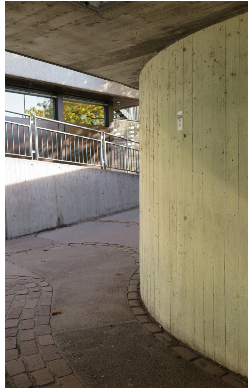
Personenunterführung zwischen Drahtschmidlisteg und Neumühlequai (erbaut 1983)
