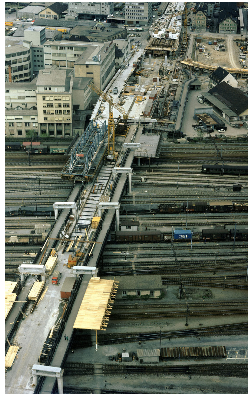
Baustelle Hardbrücke 1972 (Lindross, Björn Erik; ETH Bibliothek)
