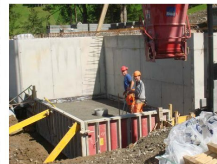
Arbeiten am Reservoir Eisenerdig im Herbst 2011
