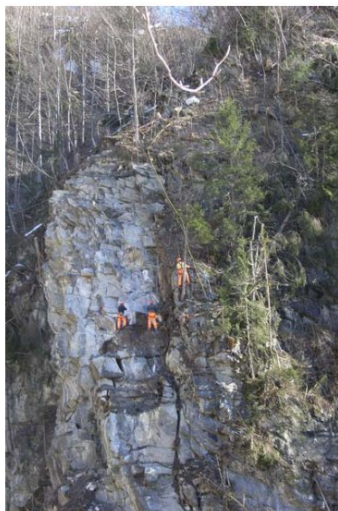
Arbeiter am Felsabtrag oberhalb des Gangbachs
