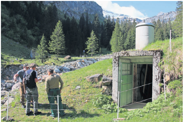
Das Wasserreservoir im Gebiet Wildenboden wird von mehreren Quellen aus dem Claridengebiet gespiesen und fasst insgesamt 300 Kubikmeter Wasser.
