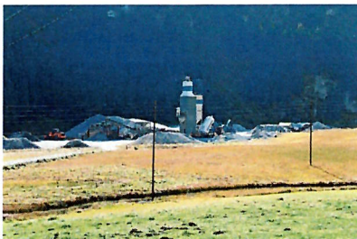
Die Konzession der Firma Walker's Söhne GmbH zur Kiesenentnahme aus dem Fätschbach wird nicht mehr verlängert. (Bild: Bruno Arnold, Urnerboden, 10. Oktober 2018)
