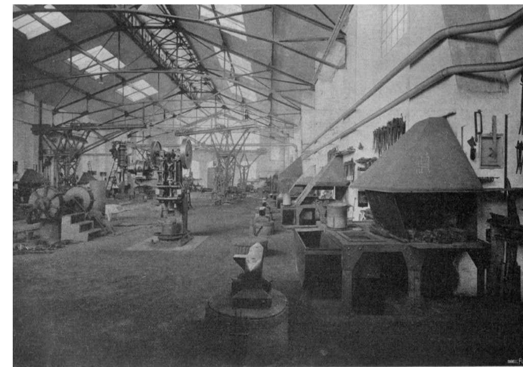
Phot. H. Nyffel. Die neuen Reparaturwerkstätten der S. B. B.: Schmiede, Totalansicht.
