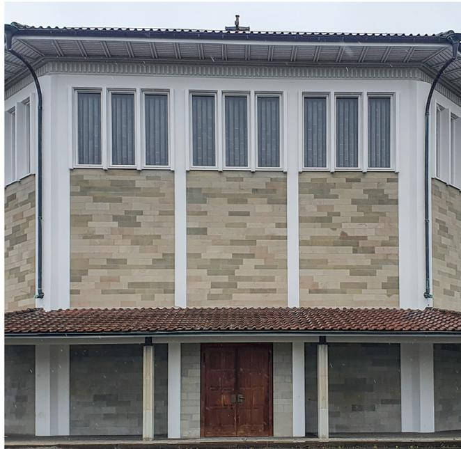
Abb. 71. Ansicht Aussen - ausgefachtetes Betonskelett
