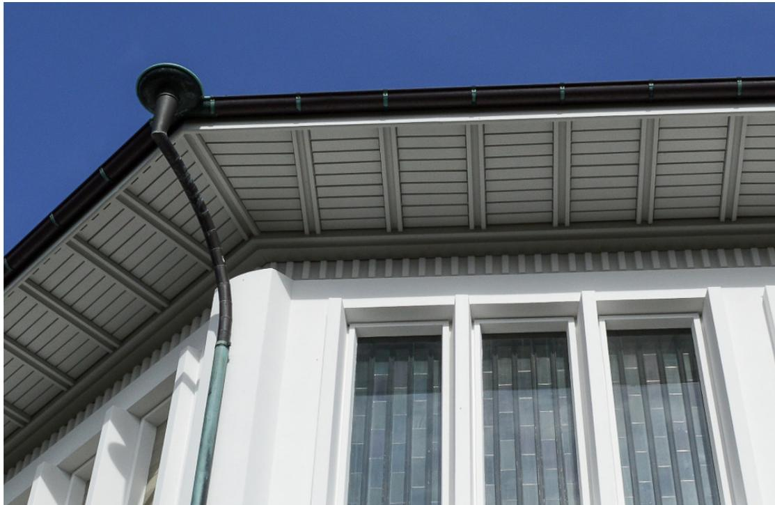
Abb. 100. Die Untersicht des Vordachs - durch die feinen Fugen wird das (Kalt-) Dach belüftet.
