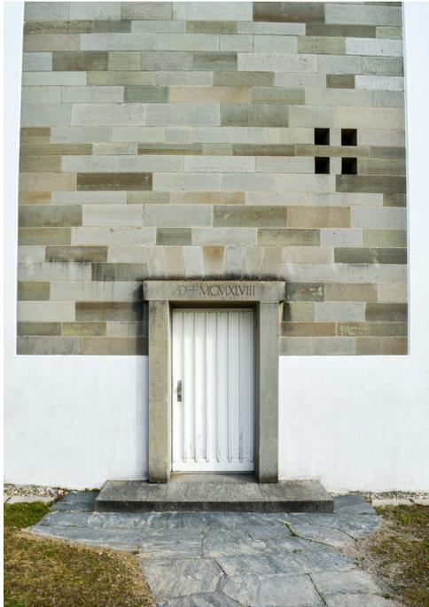
*Abb. 118. Das ausgefachte Betonskelett wie bei der Kirche*
