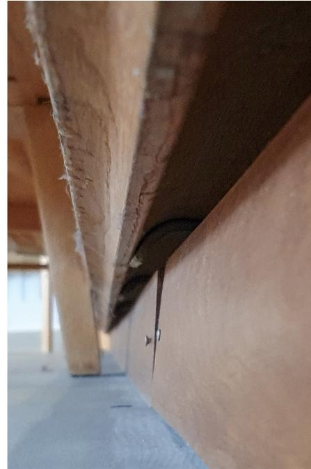
Abb. 148. Abluft Schlitz unterhalb der Treppenstufen
