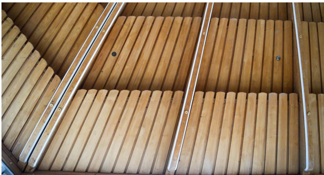
*Abb. 111. Die Holzbretter sind zwischen den Balken der Binder und den Sparren eingespannt und aufgehängt.*
