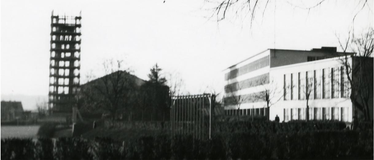
*Abb. 65. Das Betonskelett des Turms ist noch ungefüllt.*
