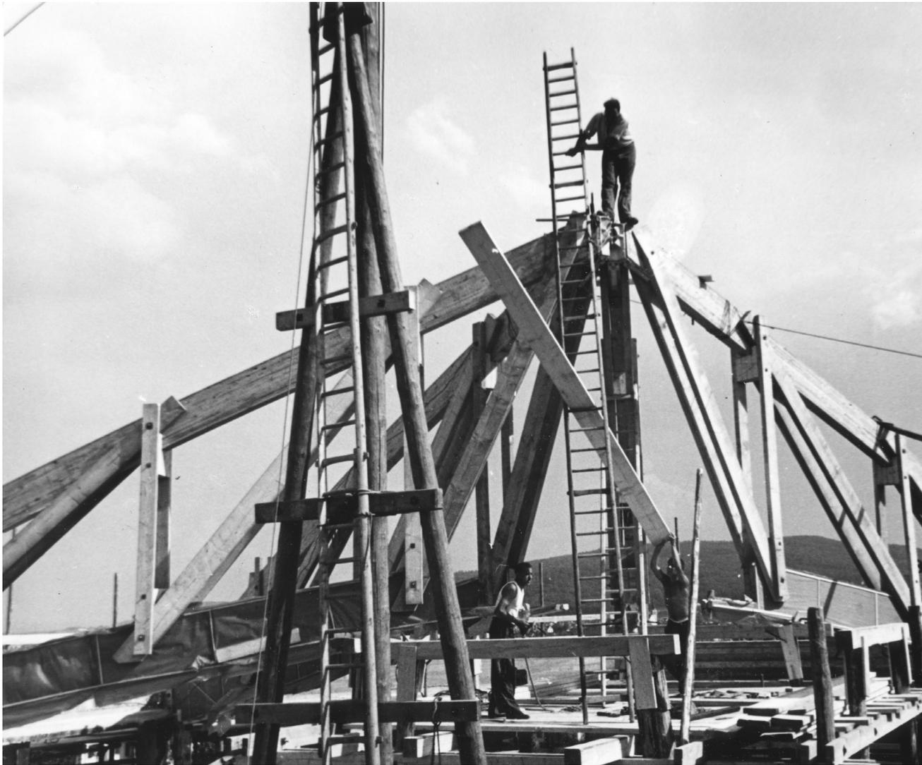
Abb. 56. Die Dachbinder schliessen sich zum Dachstock zusammen
