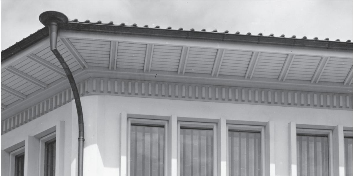
Abb. 94. Die Betonzähne oberhalb des Fensterkranz - direkt unter dem Dachgesims
