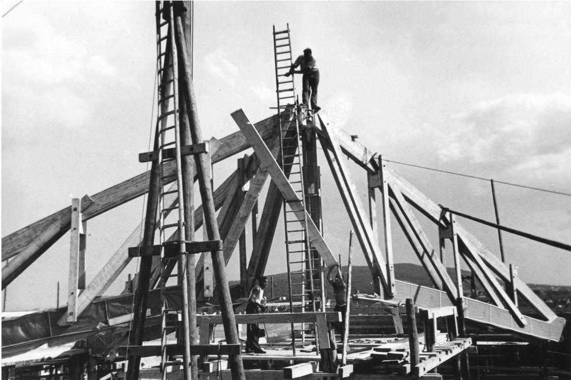
Abb. 87. Die Dachbinder auf der Baustelle. Nur die Ober- und Untergurte sind mit Querverstreben zusammengehalten und bilden eine Art Fachwerkträger.
