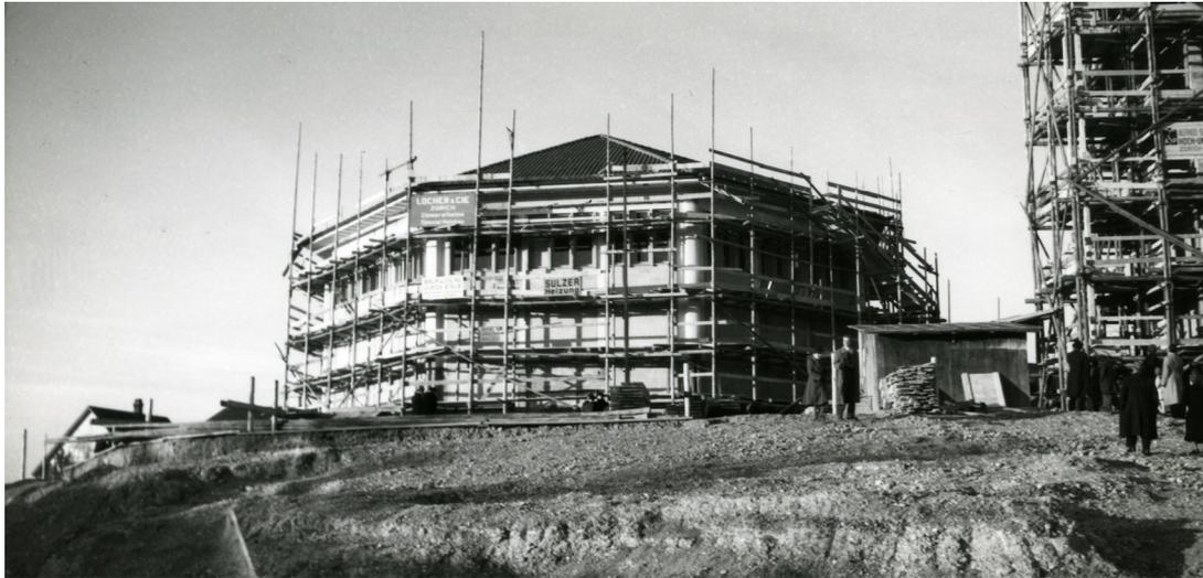
Abb. 63. Das Massive Gerüst beim Turm wurde für die Last der Sandsteine bei der Ausfachung benötigt.
