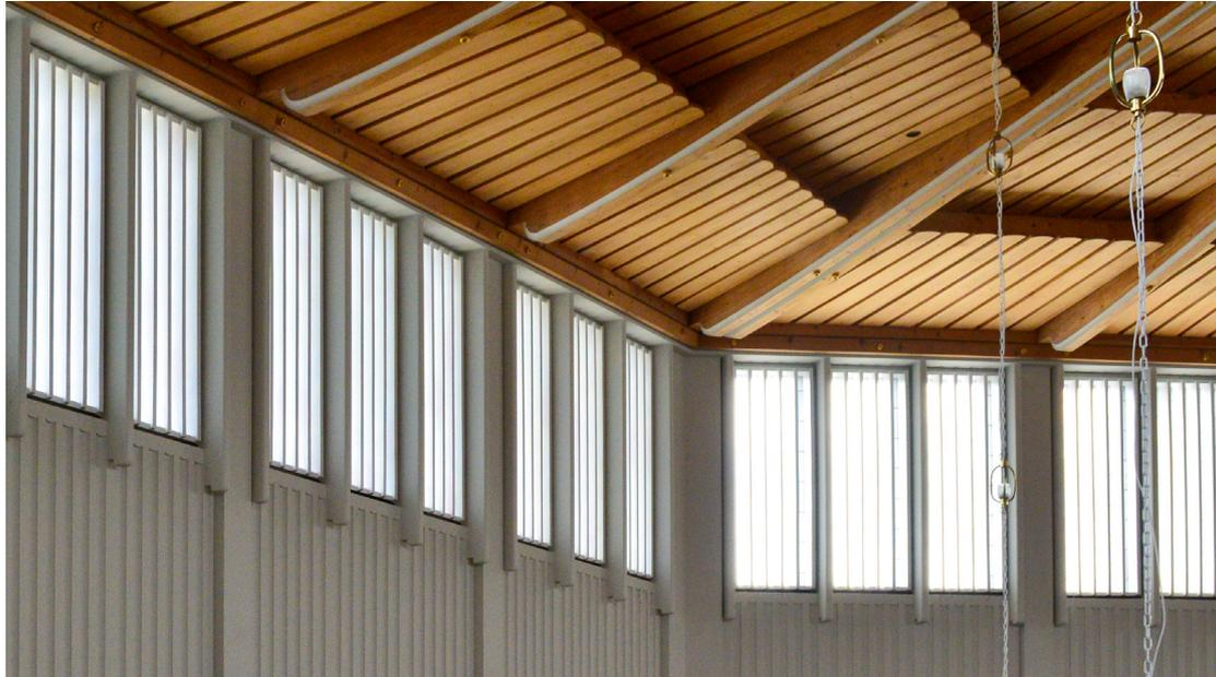
Abb. 108. Die vertikalen Elemente und die Lamellen dienen neben der Strukturierung auch als Sonnenschutz
