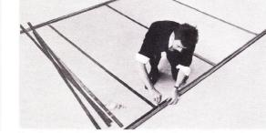
Verschrauben der Eisenprofile auf dem Zimmerboden nach dem Baukastensystem.
