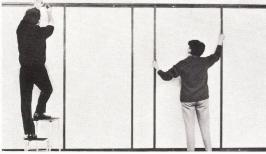
Der Trägerrahmen wird am Bestimmungsort an der Wand ausgerichtet — die vorhandene Lochung der Trägerschiene dient als Lehre für das Anbringen der Dübel.
